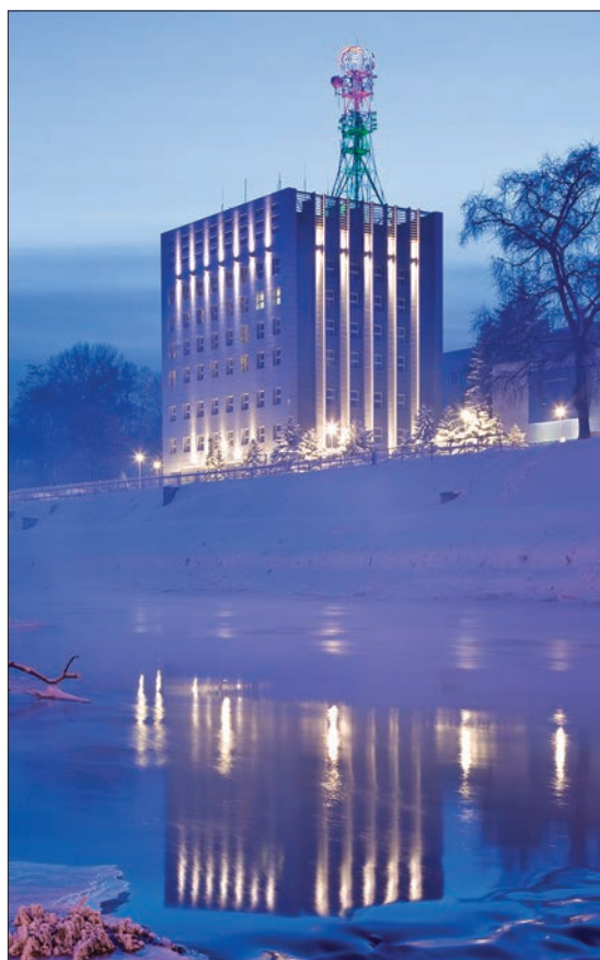
Budynek techniczny spółki PGE Dystrybucja S.A. Oddział Rzeszów
