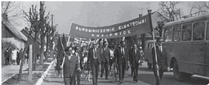
Na etapie projektowania najważniejszym zadaniem było zapewnienie zaplecza budowniczym elektrowni i jej załodze – to w sumie ok. 8 tys. ludzi, którzy mieli osiedlić się w Kozienicach i Świerżach Górnych
