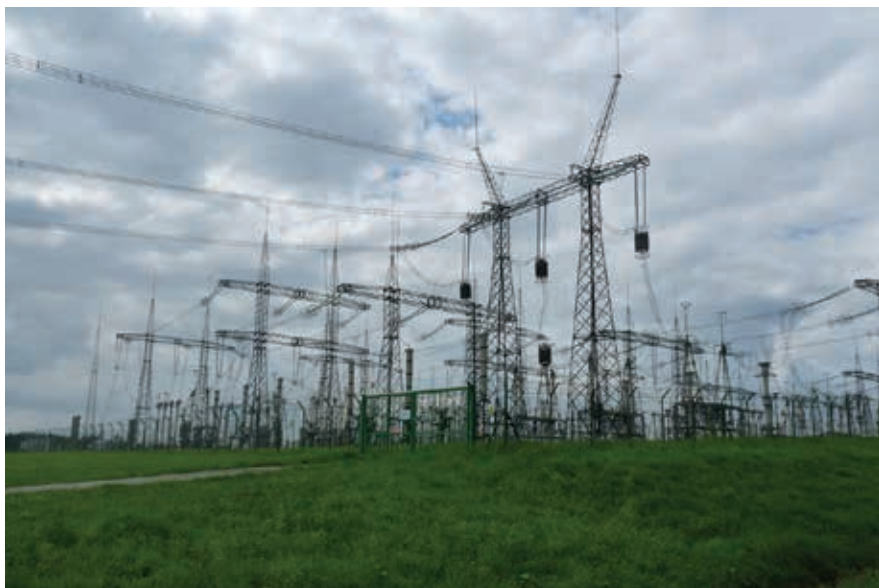
Stacja Elektroenergetyczna 750/400/110 kV w Widelce.
