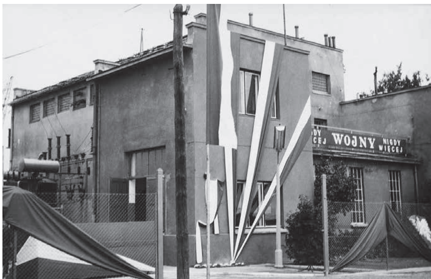
Stacja Transformatorowa Staroniwa
