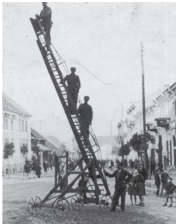
Monterzy na drabinie przy pracy na ul. Kilińskiego
