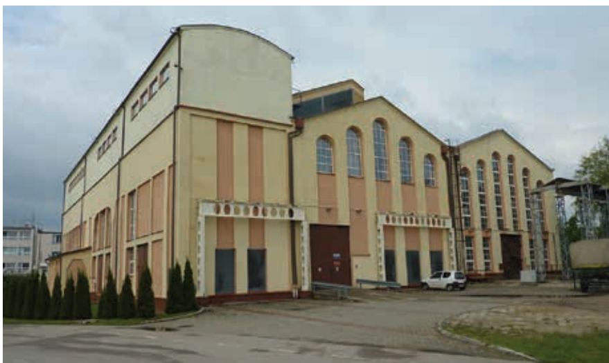
Budynek elektrowni wspólnie
