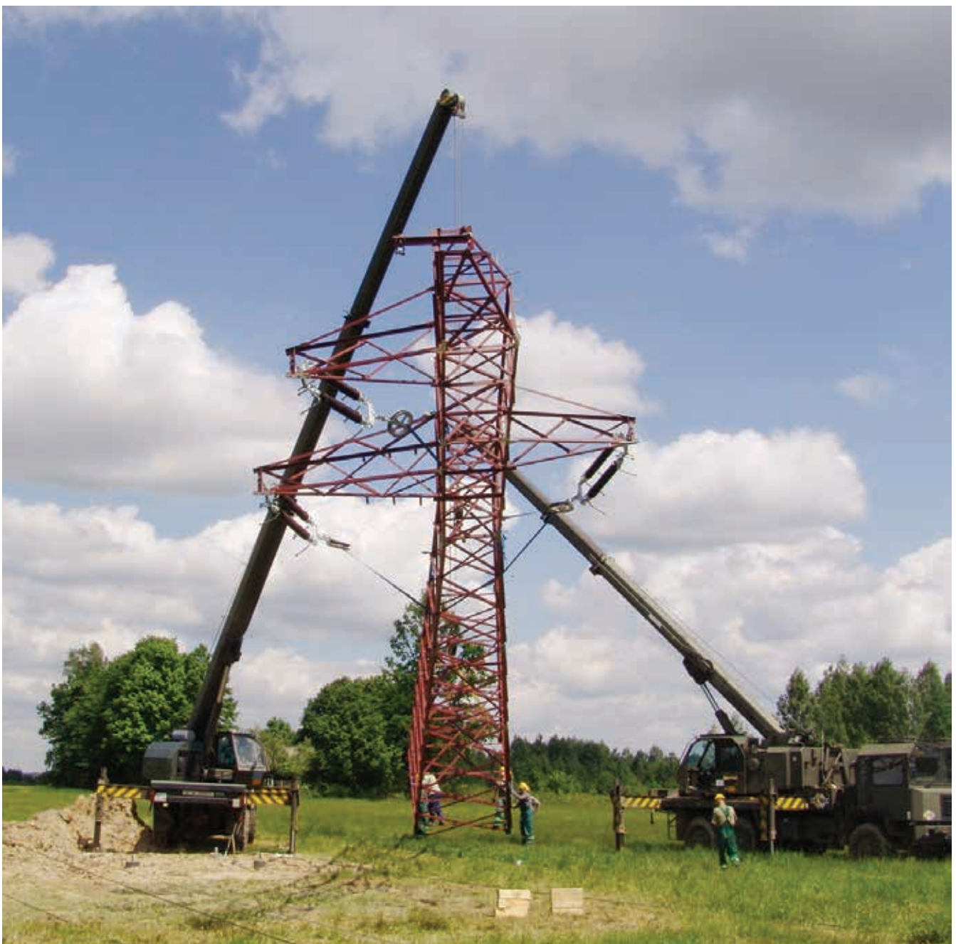
Budowa linii wysokiego napięcia 110 kV, relacja Adamowo-Siemiatycze (PGE Dystrybucja SA)
