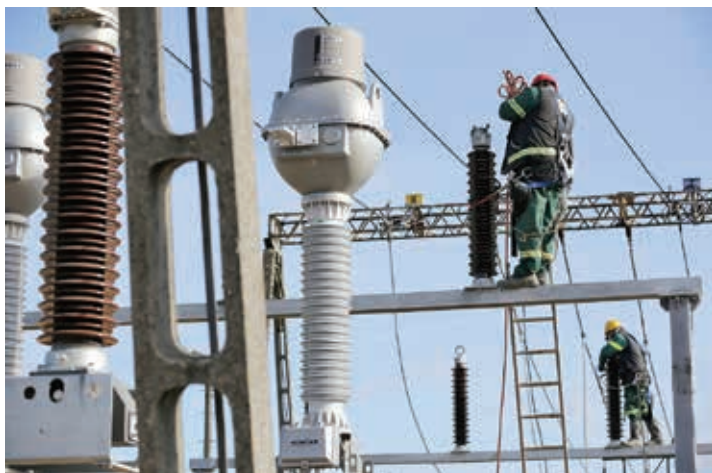
Modernizacja stacji 110/15 kV w Hajnówce (PGE Dystrybucja SA)
