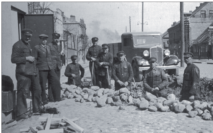
1922 r. – załoga w trakcie układania kabla
