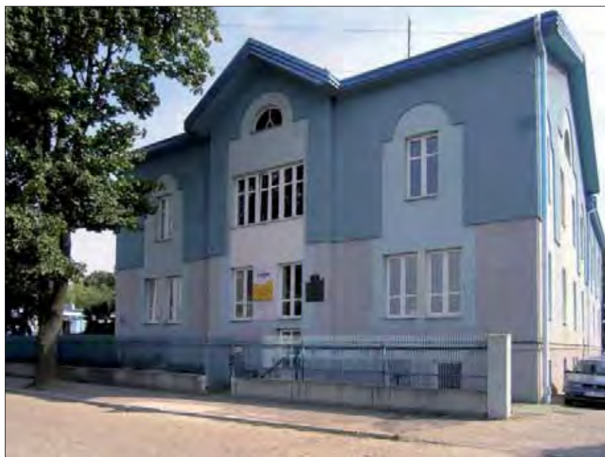
Siedziba Rejonu Dystrybucji Tarnów Teren w dawnym budynku Elektrowni Miejskiej
