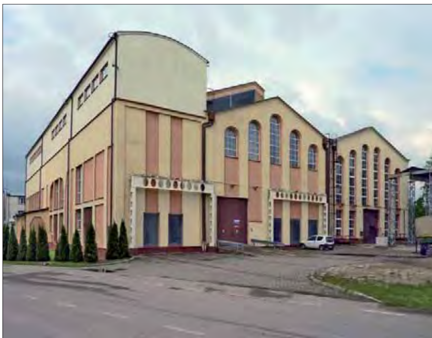
2002 r. – RPZ-3 w Białymstoku (dawny budynek elektrowni)
