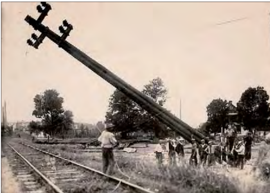
Budowa linii 30 kV Wojnicz-Bochnia, 1938 r. Budowa realizowana przez OZET
