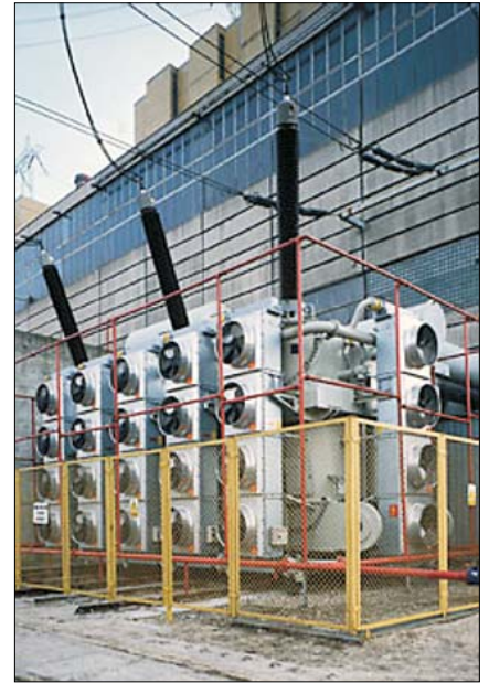
Transformator 500 MW
