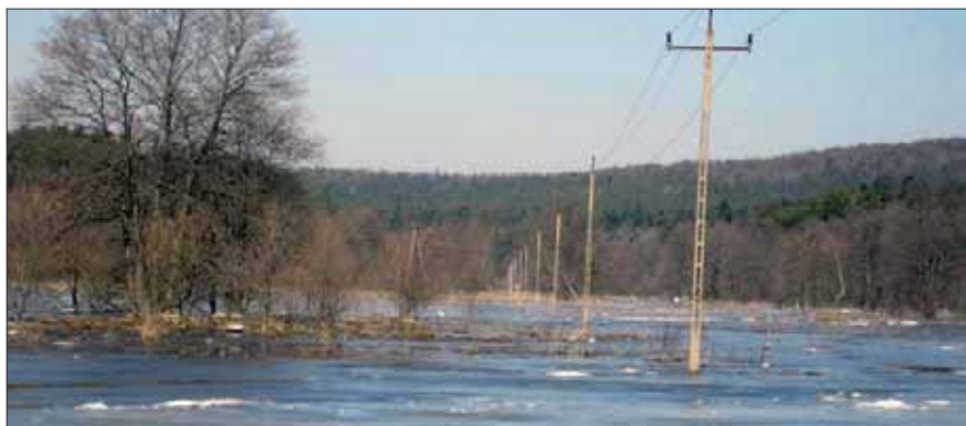
Przebudowa linii w Roztoczańskim Parku Narodowym
