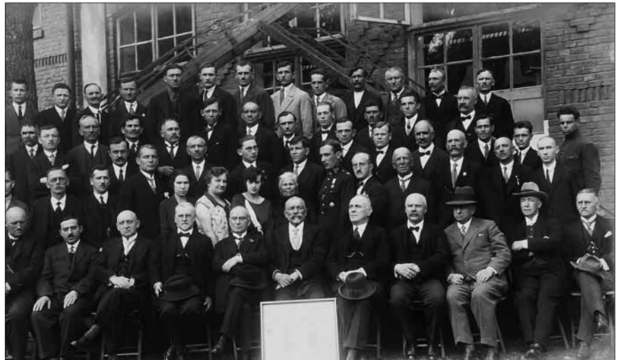
Załoga rzeszowskiej elektrowni w 1929 roku
